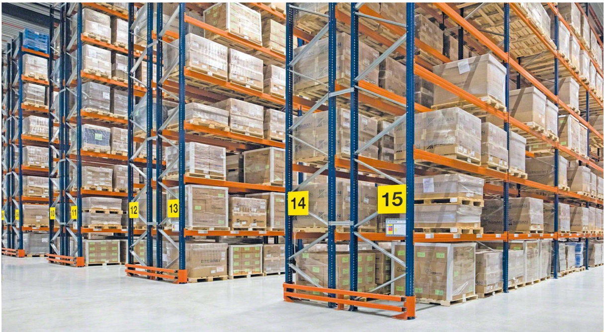
Figure 9 : Exemple de stockage en racks
